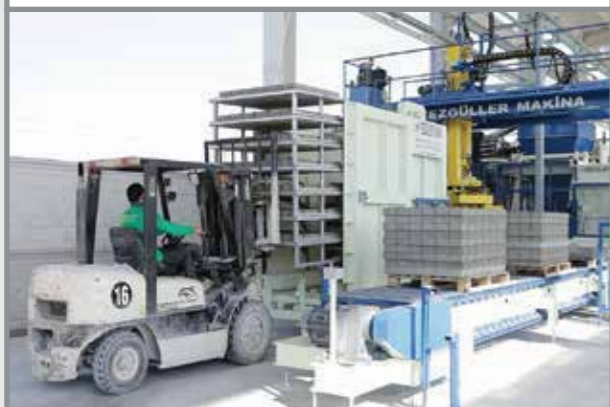
Башня входа поддонов
